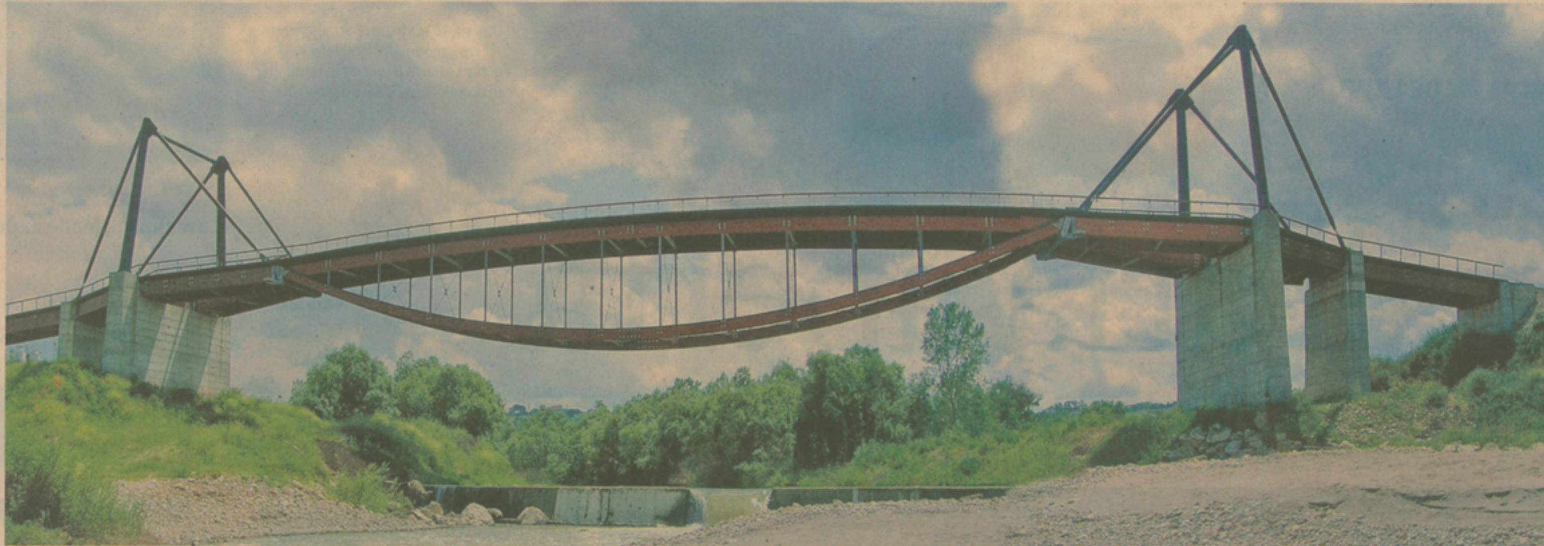
Ponte ciclabile. Costruito nel 2007 sul fiume Calore, in località Ponte Valentino (Benevento)
