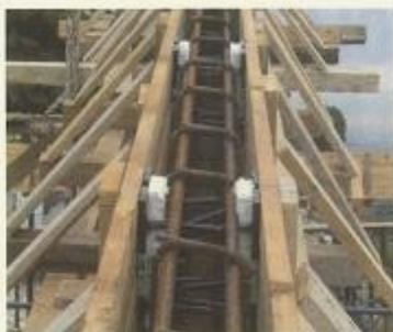
FISSAGGIO DEGLI ELEMENTI COULISSE NELLE CASSEFORME
