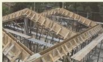
TUTTO E' PRONTO PER IL GETTO DEL CALCESTRUZZO
