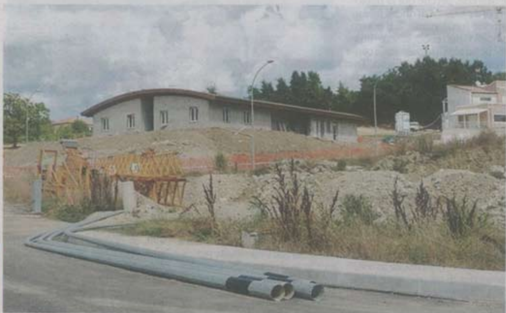
Il cantiere per il nuovo asilo di San Biagio di Osimo
